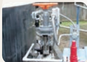
バルブ自動開閉器(ベストルク)
